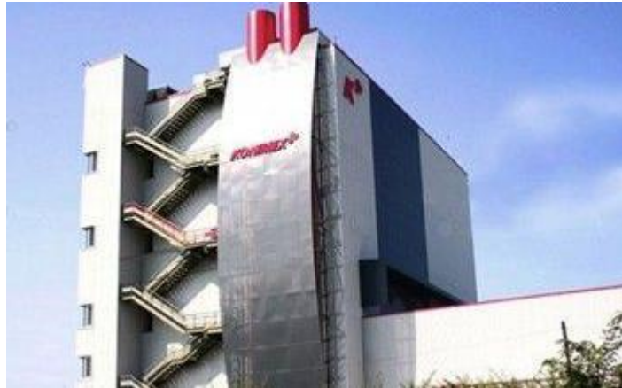
Gambar 1.4 Gedung PT Konimex
